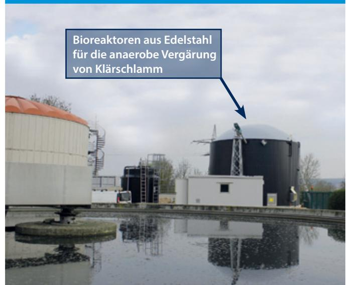
Bioreaktoren aus Edelstahl für die anaerobe Vergärung von Klärschlamm
